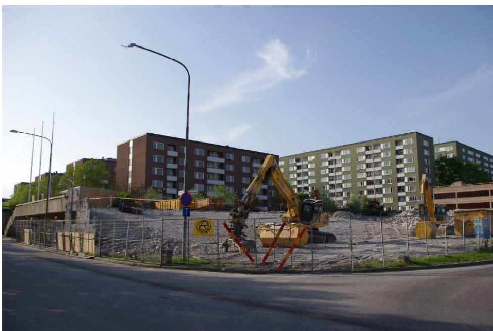
Hörnet Rinkeby Allé / Hjulstavägen. På platsen fanns tidigare en byggnad för stadsdelsförvaltningens administration. Byggnaden revs eftersom den inte bedömdes vara möjlig bygga om till annan verksamhet.
