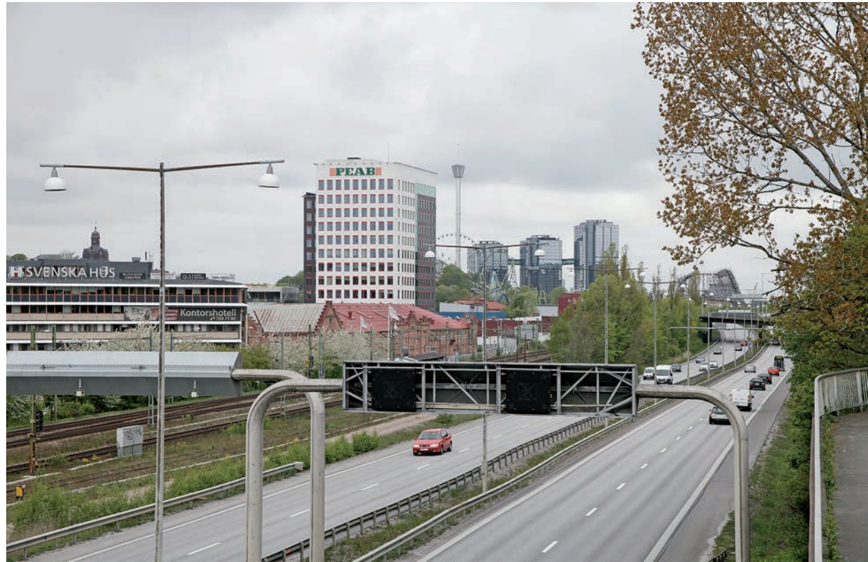
Vänster: ÅF-huset, Kallebäck, Örgryte, Göteborg Ovan: A-huset, Lyckholms, Almedal, Göteborg Foto: Pär Eliaeson
