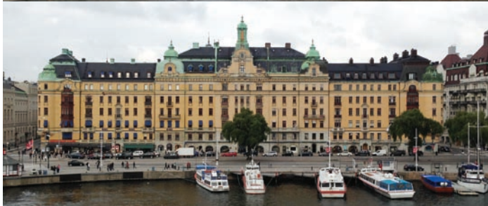
13. Skarpnäck. Skarpnäcks allé. 14. Kv Bodarne. Fasad mot vattnet.
