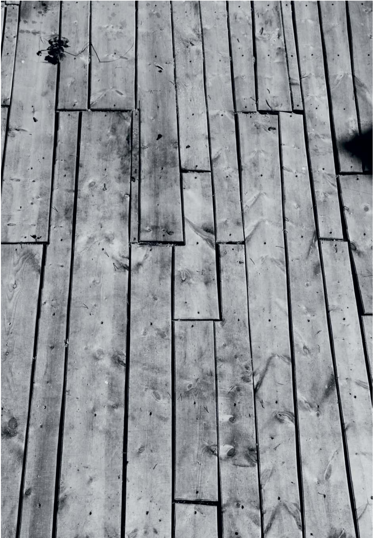
Golvet till friluftsateljén är ett fullständigt originellt brädpassel där varje handsågad planka måttpassats individuellt.
