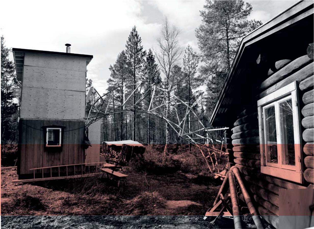
Från verkstaden går det en fackverksbåge över till kökshuset. Byggt endast för att hänga en förlängningssladd på.
