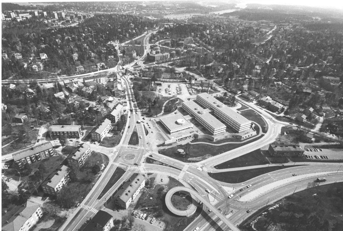
02. Flygbild över det nybyggda stadshuset c:a 1975, Lidingö stads arkiv. Foto: Bo Carsing
